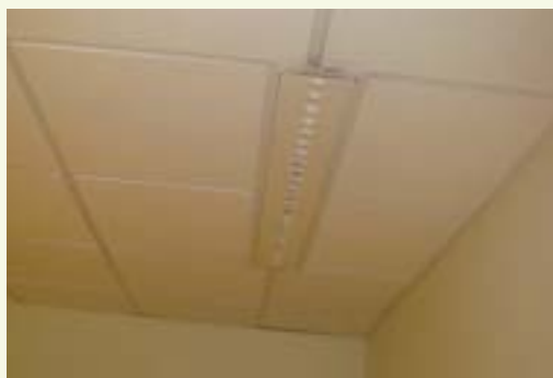
Diffuseur plafonnier avec buses orientables
