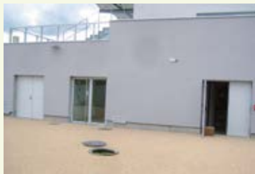
Accès Nourice Installation géothermie sur sondes
