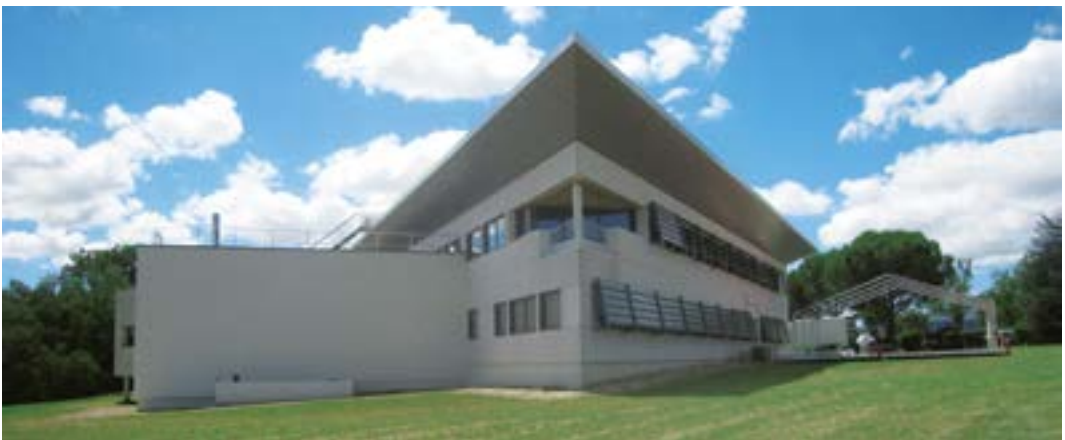
Espace BTP 26/07, implication conjointe des entreprises et des usagers pour atteindre les performances visées - SORHA
